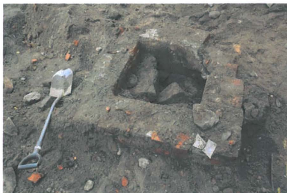
Kuva 17. DG 2233: 37 Rakenne 6 "Viemäri" on luultavasti 1900-luvun alussa käytöstä poistettu viemäri.
