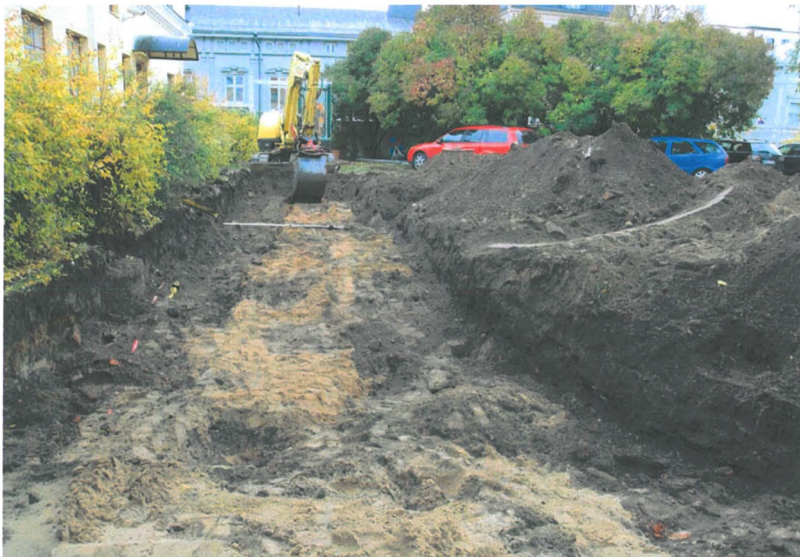
Kuva 2. DG 2233:3 Moderneja putkikaivantoja tontin pohjoisosassa.
