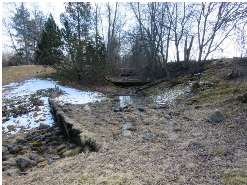
Kanavan patoja, etualalla pohjoisin pato. Kuva etelään.
